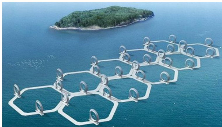
Figura 1.4: Sistema a nido d'ape con turbine eoliche in serie e a forma di grandi lenti capaci di catturare il vento in mare aperto, sviluppato dal Prof. Yuji Ohya della Kyushu University. Immagine adattata da [3].
